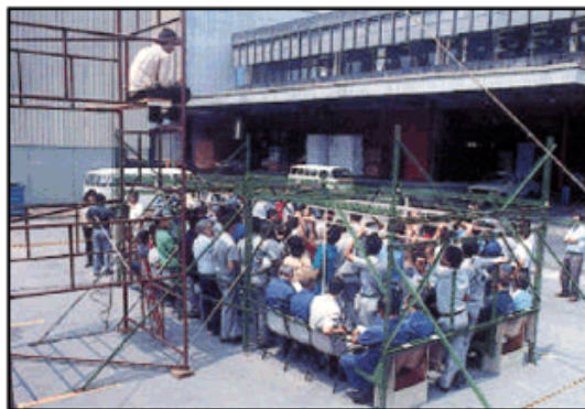
Figura 1 – Vista geral do mock-up
